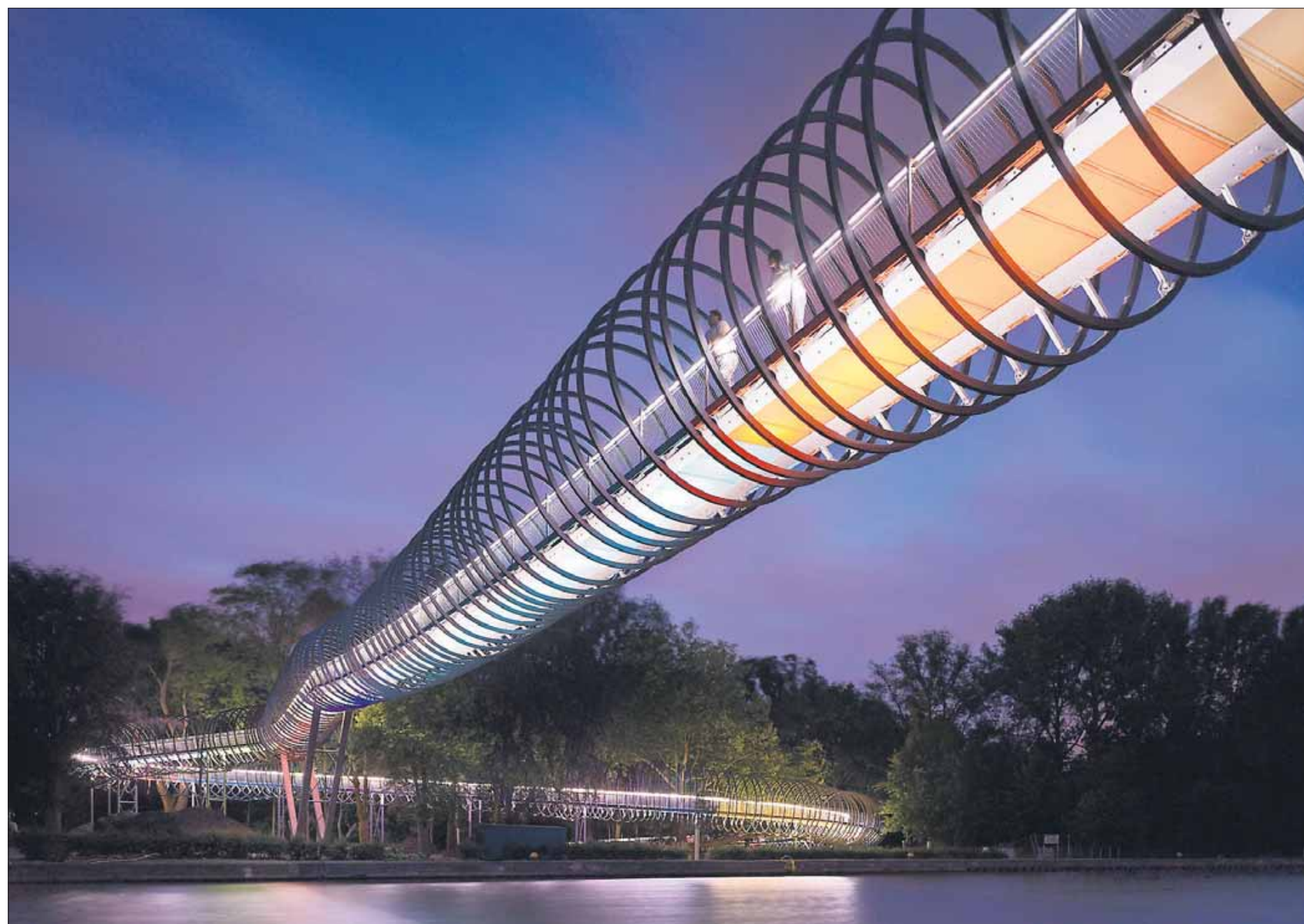
Elegante Umwege und Drehungen: Tobias Rehbergers Brücke über den Rhein-Herne-Kanal.
